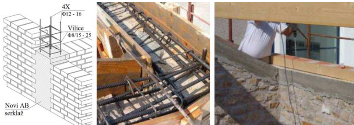
Slika 24 Pojačanje neomeđenih zidanih zidova izvedbom AB serklaža
