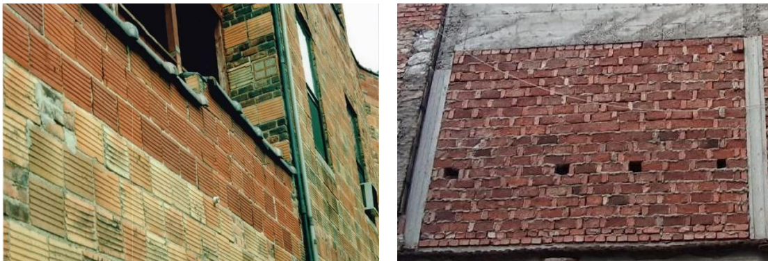
Slika 8 Primjer seizmički neprimjerenih zidanih zidova s blok opekama s horizontalnim šupljinama i šupljeg zidanog zida od pune opeke
