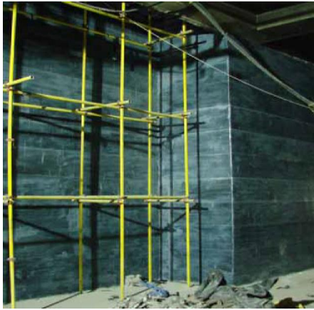
Slika 13 Primjer pojačanja postojećih AB konstrukcija ovijanjem FRP-om ili izvedbom dodatne AB obloge
