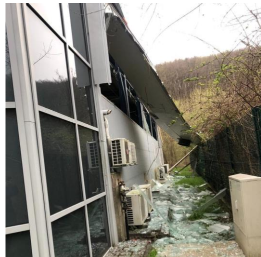
Slika 14 Fotografije otkazivanja dijagonala vezova u potresu, te oštećenja pročelja i stakala zbog velike fleksibilnosti okvirnih konstrukcija
