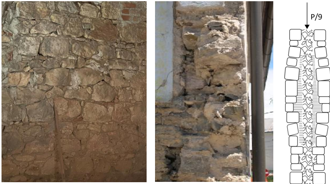
Slika 5 Fotografije zidanog zida od lomljenog kamena
