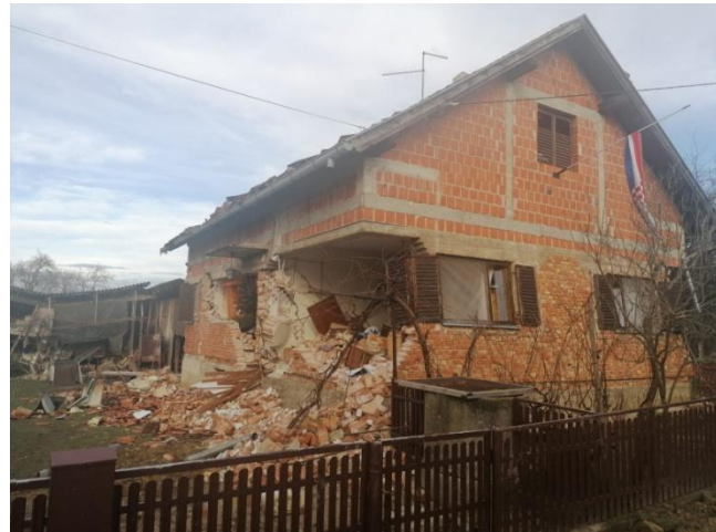
Slika 3 Fotografije oštećenja zgrada od nearmiranog ziđa s betonskim stropovima
